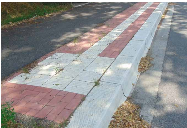
Fehlerhafte Ausrichtung der Rippenplatten
