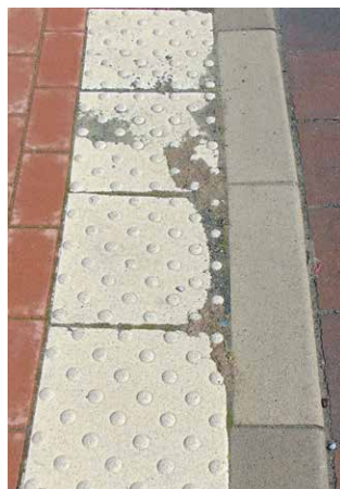
Verschmutzung durch abgesenkte Bodenindikatoren
