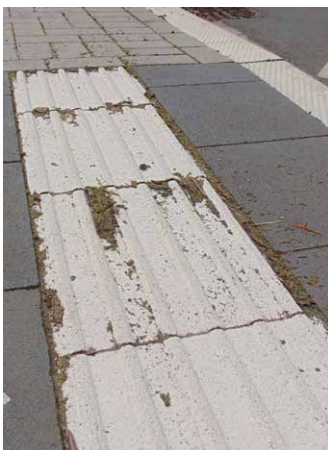
Verschmutzung durch abgesenkte Bodenindikatoren
